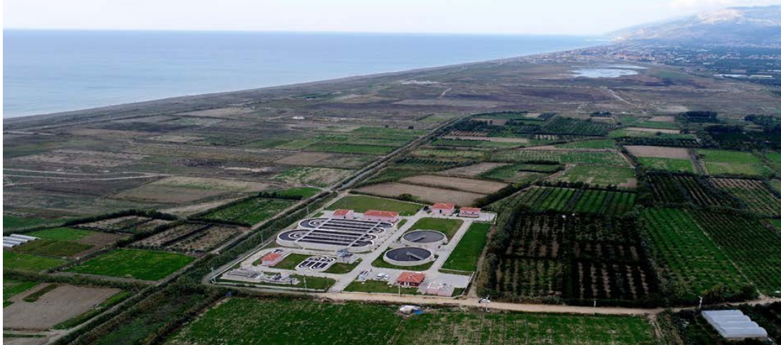
Görsel 1 Samandağ Atık Su Arıtma Tesis
